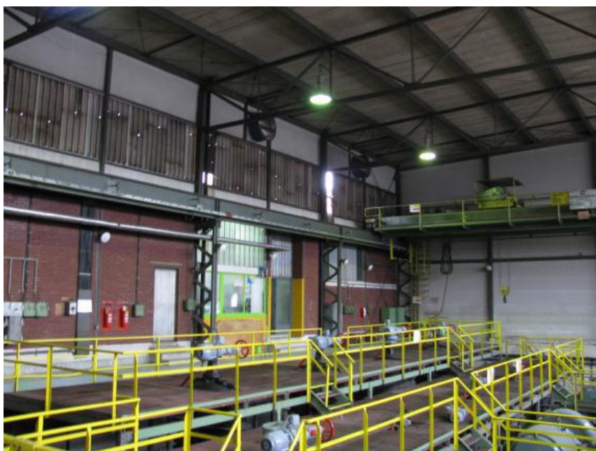
Slika 6. Unutrašnjost objekta PS-4
